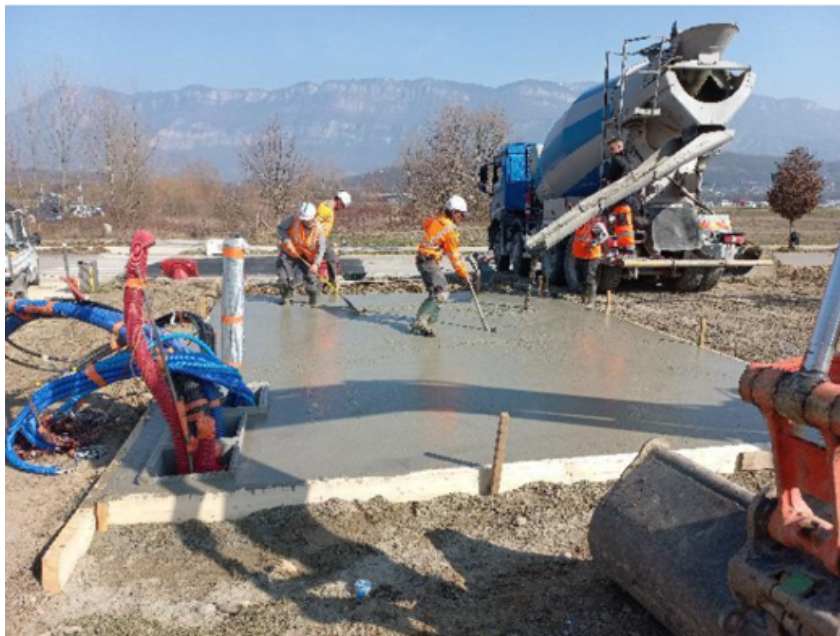
FIGURE 2.15 – Dalle en béton de du stockage thermique
