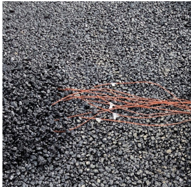
FIGURE 2.20 – Thermocouples type T posés dans la chaussée
