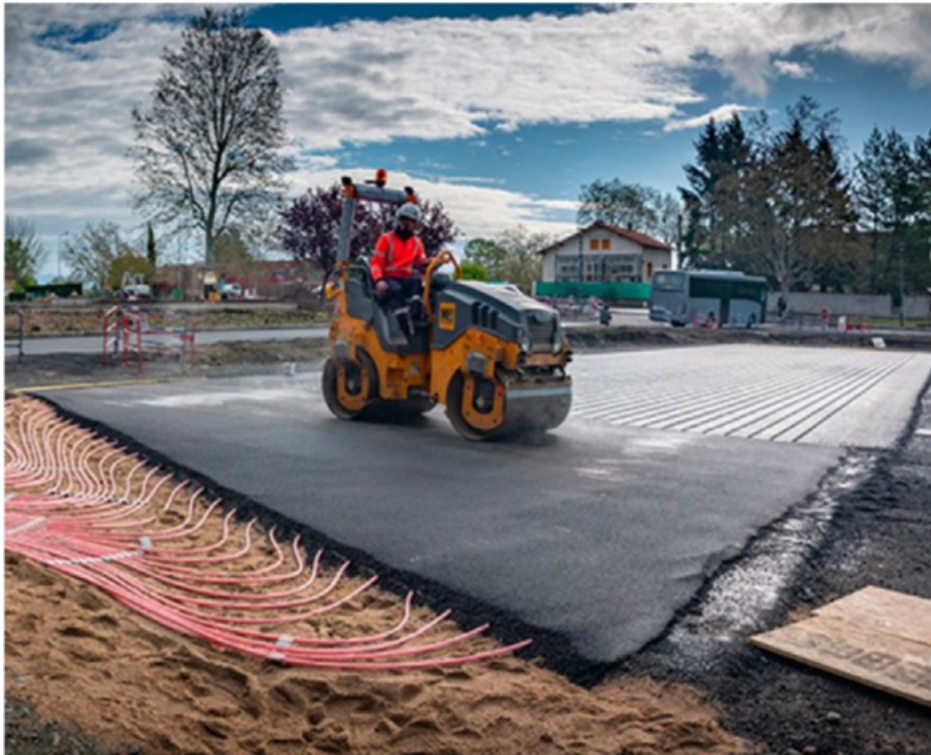
FIGURE 1.9 – Un chantier de route thermique Power Road de Eurovia [23]
