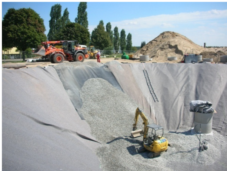
FIGURE 1.29 – Remplissage du PTES de Eggenstein-Leopoldshafen[40].
